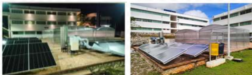
Figura 2. Planta de secado solar tipo invernadero. Foto de autor.
